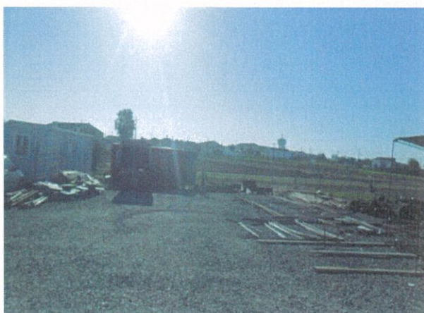
Fotografia 9 – Área de Apoio à Produção: Contentor do Subempreiteiro Metacrescente
