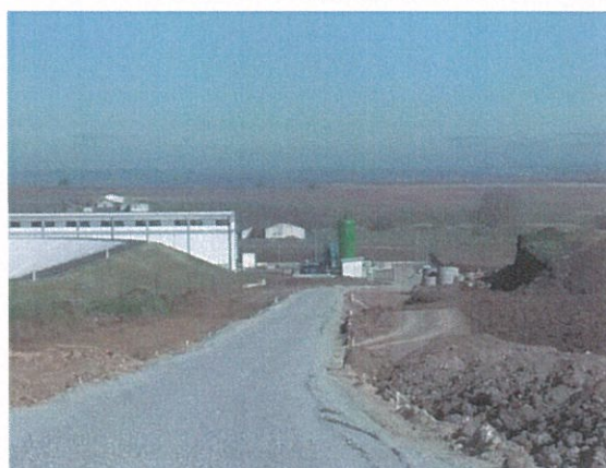
Fotografia 24 – Caminho de Acesso à Estação Elevatória (Situação Atual)
